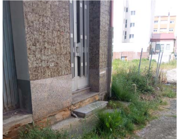
Portal final de C/ Esquío
